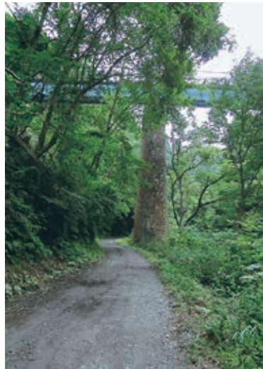
JR 山田線の古い鉄橋の下を通る
